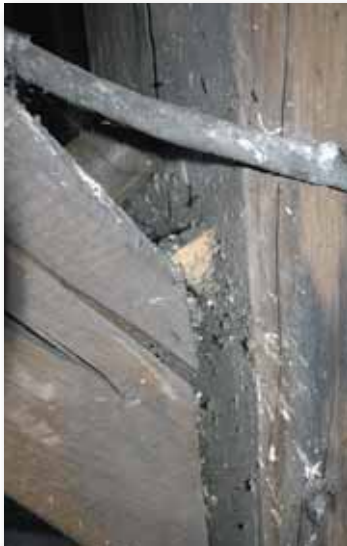
Plusieurs pièces de la charpente sont pourries en raison des problèmes d'étanchéité.
