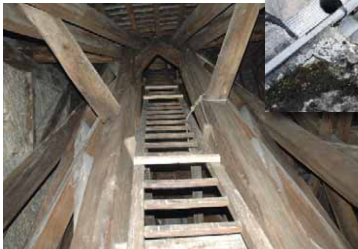
Plusieurs pièces de la charpente sont pourries en raison des problèmes d'étanchéité.
