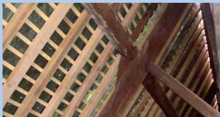
toute la charpente de la nef a été refaite
